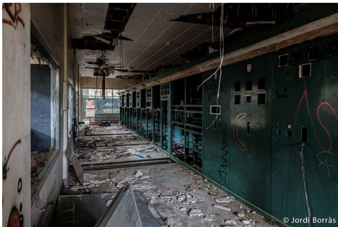
Interior de Planta Dièsel de Ràdio Liberty. © Jordi Borràs, 2022.
