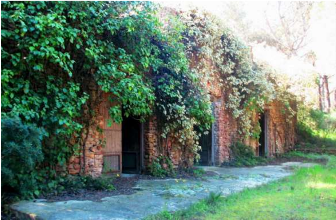
Botigues de pescadors que formen part de la vila marinera dins el perímetre dels terrenys de Ràdio Liberty.
